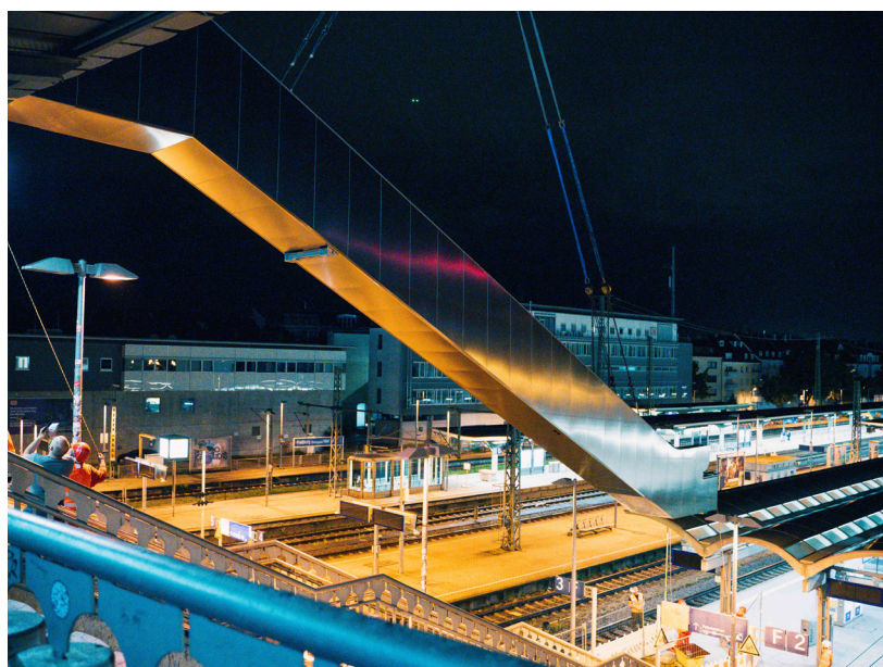
Abb. 2 & 3: Bei Nacht eingebaut, für tägliche Bewegung – die neuen Fahrtreppen schaffen Verbindung zwischen Stadt und Region
