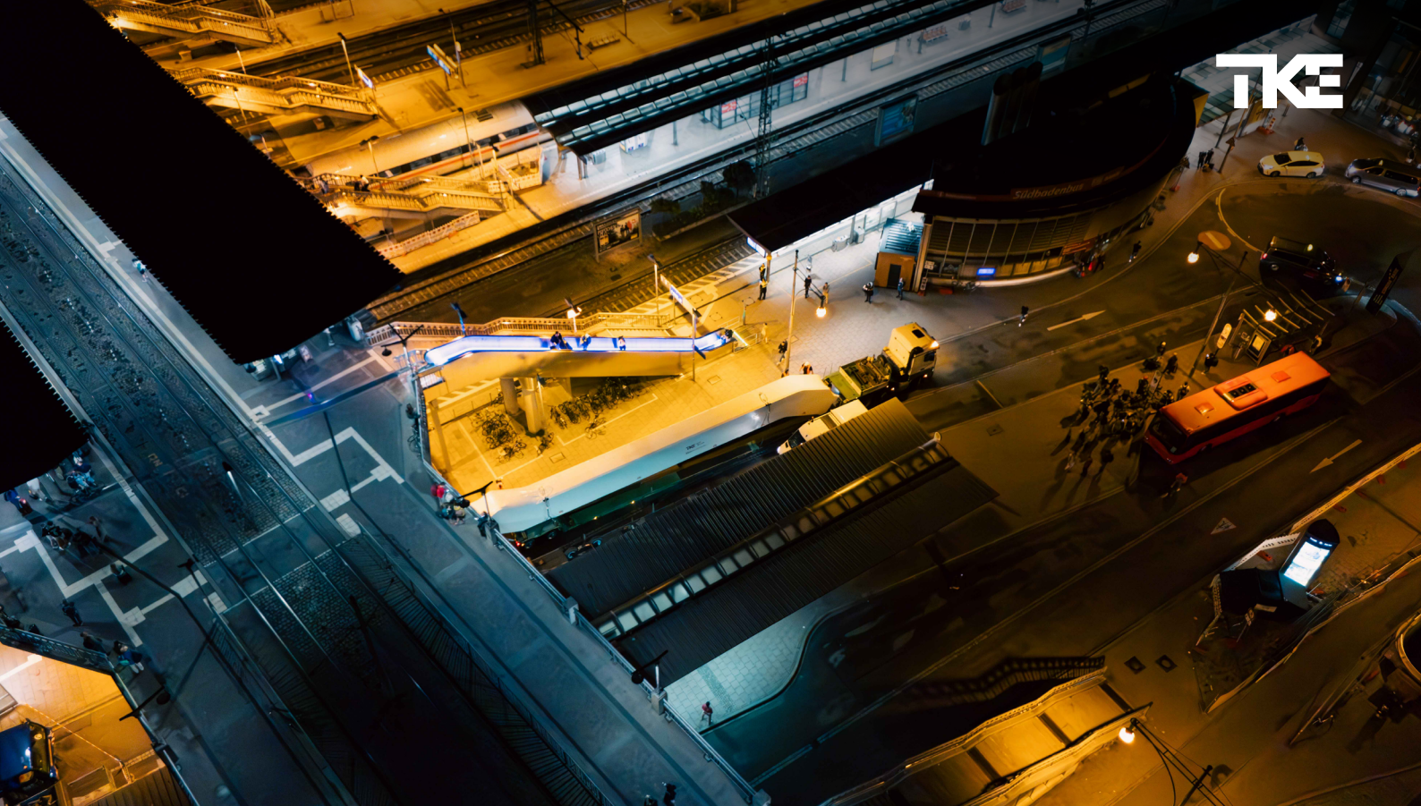
Abb. 1: Mobilitätsknotenpunkt in Freiburg im Breisgau – wo die Stadtbahn mit dem Hauptbahnhof durch neue Fahrtreppen von TKE verbunden wird
