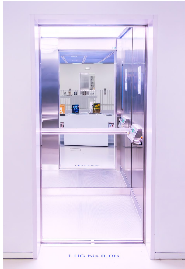
Abb. 3: Aufzugskabine VORHER und NACHHER im Vergleich
