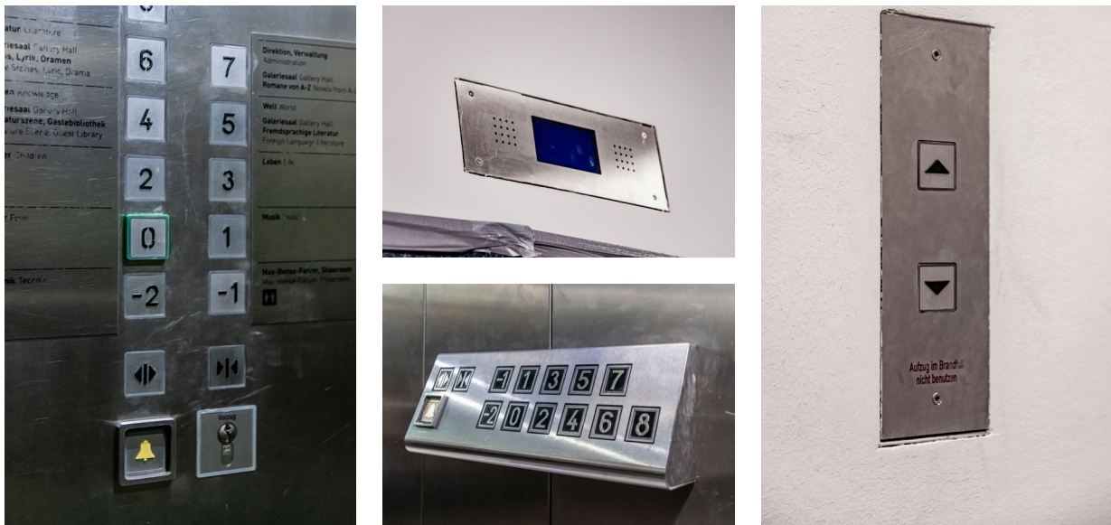
Abb. 4: VORHER: Anzeige- und Bedienelemente rund um die Aufzugskabine
