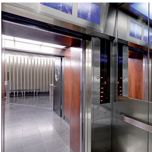
Abb.10: Kabine mit neuer I-Lamelle nachher
