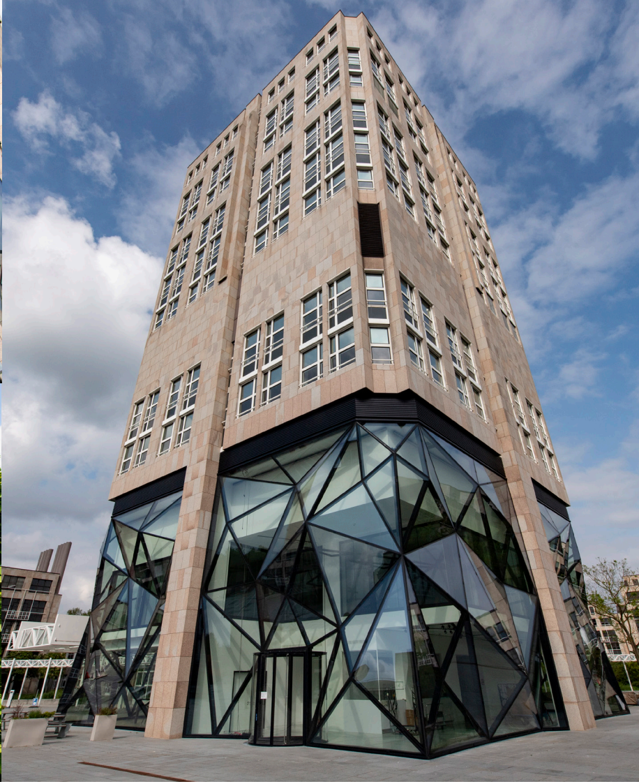
Abb. 1: Ansichten Campus Sternhöhe, Stuttgart Möhringen
