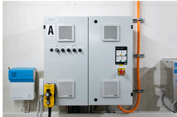
Abb. 7: Steuerung und Antrieb nachher
