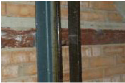
Ankerplatten für Schweißarbeiten
