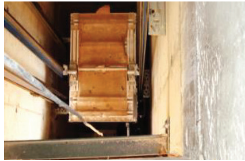
Ringanker für Bohrarbeiten
