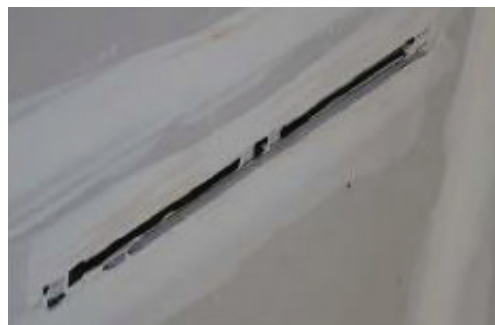
Trockenwand-Ankereisen: Diese Ankereisen bündig mit der Wand anbringen (mit einer oder zwei Schichten Rigipsplatten).
