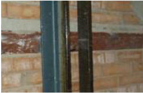
Ankerplatten für Schweißarbeiten
