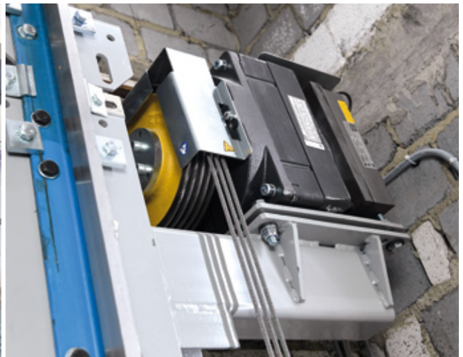
Abb.12: Antrieb nachher integriert im Aufzugsschacht
