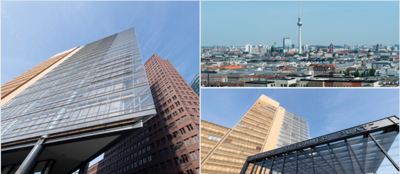
Abb. 1: Ansichten Bürokomplex Brookfield Property Germany GmbH
