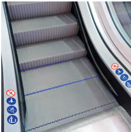
Belysning av spalt mellom trinn i av- og påstigningsområde
