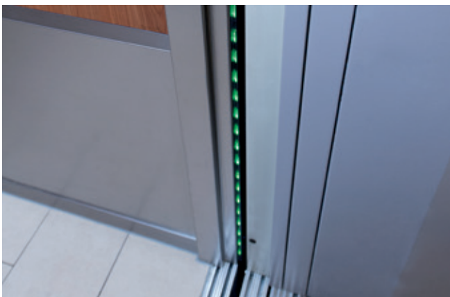
Abb.15: Bodenbündige Aufzugspositionierung und LED-Sicherheitslichtgitter nachher
