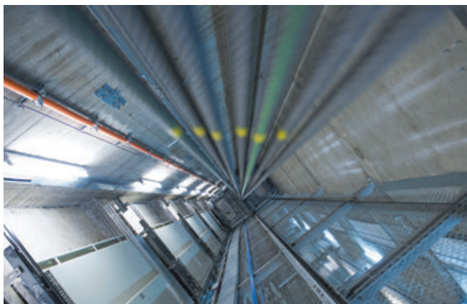
Abb.14: Blick in den Aufzugsschacht mit neuen Kabinen- und Schachttüren nachher
