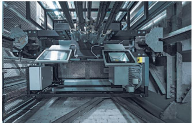
Abb.15: Scheinwerfer für Blick in den Schacht während der Fahrt nachher
