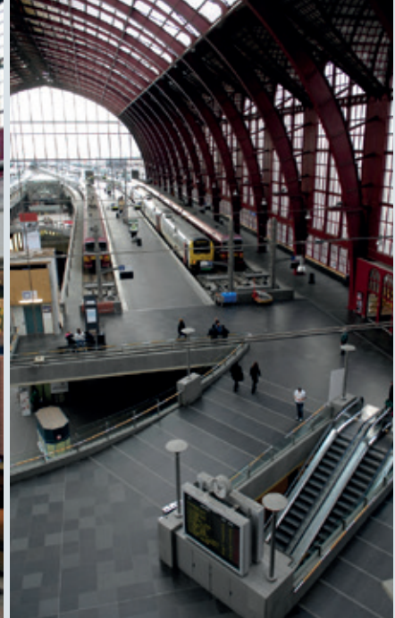
Abb.3: Ansicht von oben
