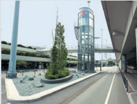
Abb.2: Aufzugsturm vor dem Parkhaus
