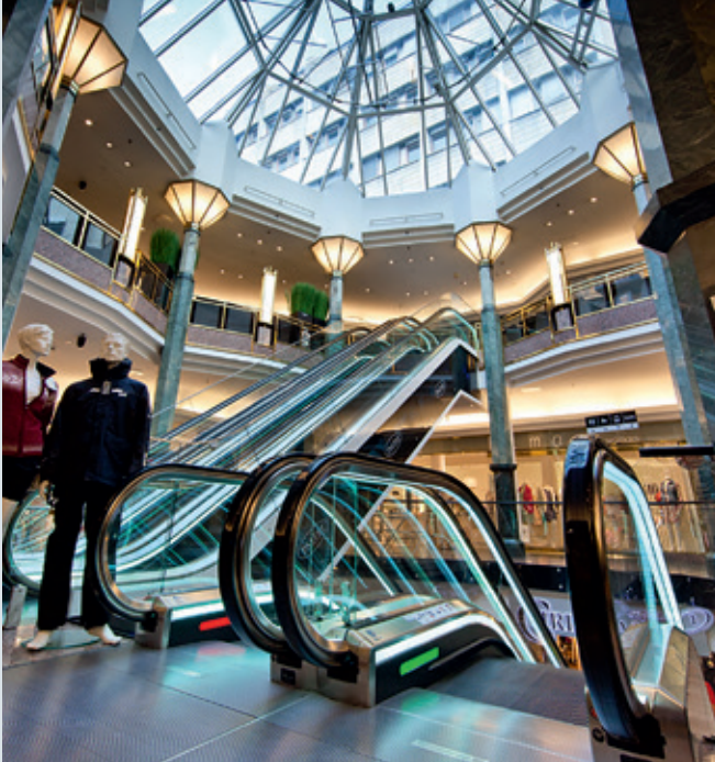
Abb.1: Die hochwertigen Fahrtreppen integrieren sich mühelos in das noble Umfeld
