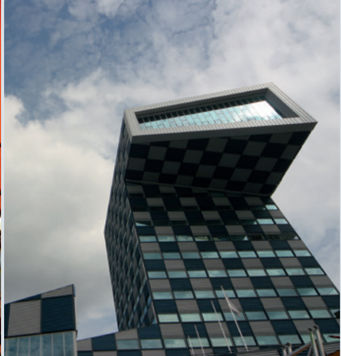
Abb.2: Außenansicht der SCT
