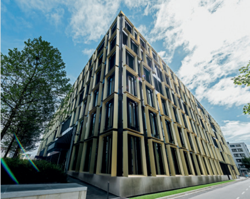
Abb.1: Außenansicht des Bürogebäudes MK9
