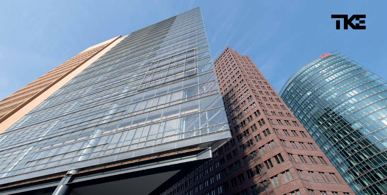
Abb.1: Ansichten Bürokomplex Brookfield Property Germany GmbH
