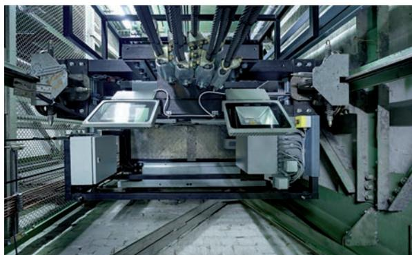
Abb.15: Scheinwerfer für Blick in den Schacht während der Fahrt nachher
