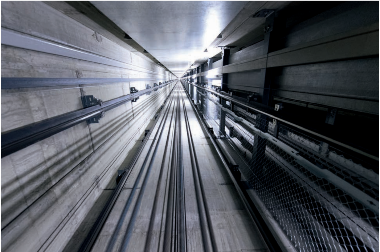
Abb.20: Blick in den imposanten Aufzugsschacht
