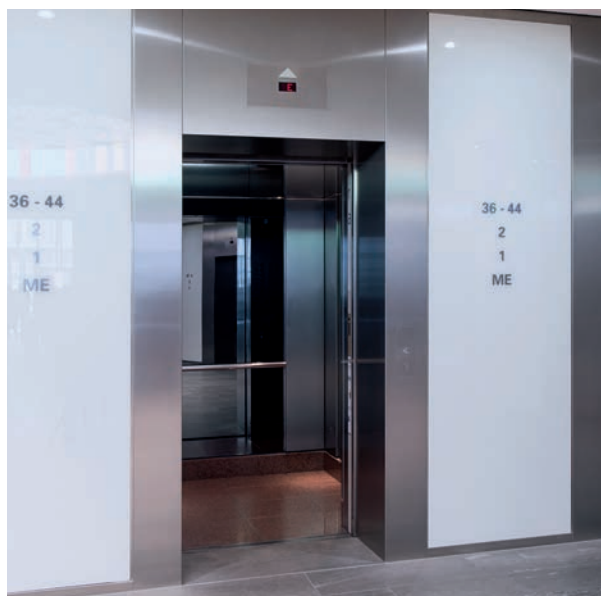
Abb.2: Aufzugskabinen in Gruppenansicht vorher
