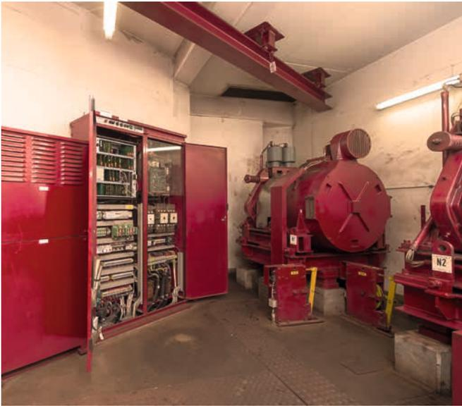
Abb.15: Maschinenraum inkl. Aufzugssteuerung vorher
