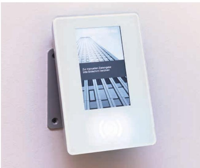
Abb.8: Intelligente Zielauswahlsteuerung nachher
