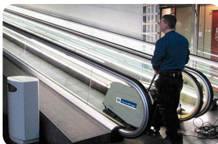
Trinn- og palettrengjøring
