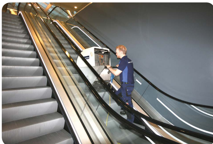
Trinn- og palettrengjøring
